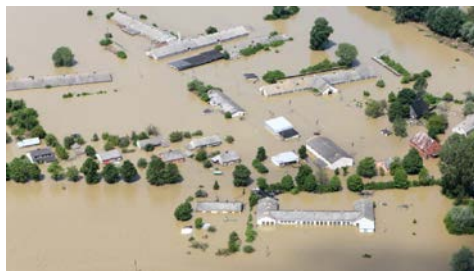
Przerwany wał w Świniarach
