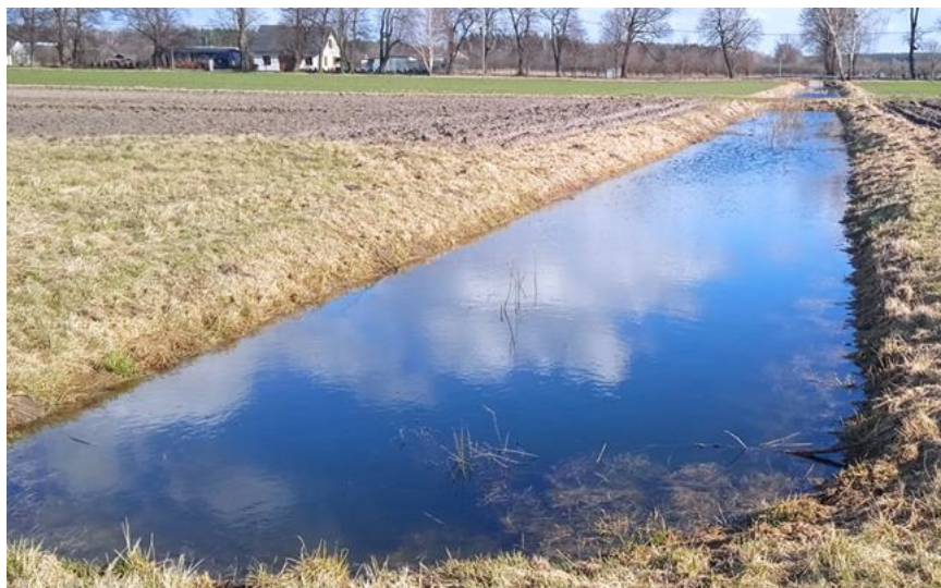
Rys. 3.17. Rów melioracyjny przed konserwacją, Wola Pasikońska, 02.2022; źródło: Gminna Spółka Wodna „Kampinos”
