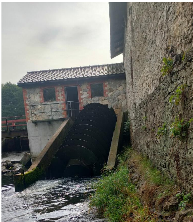
Rysunek 7. Mała elektrownia wodna w Wolicy – stan aktualny
